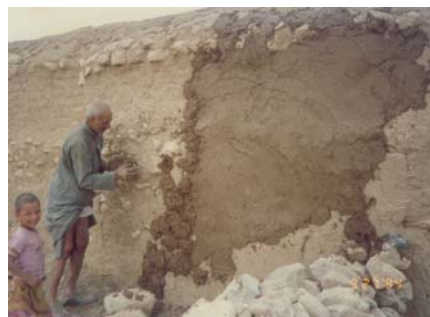
日干し煉瓦定住家屋の補修
